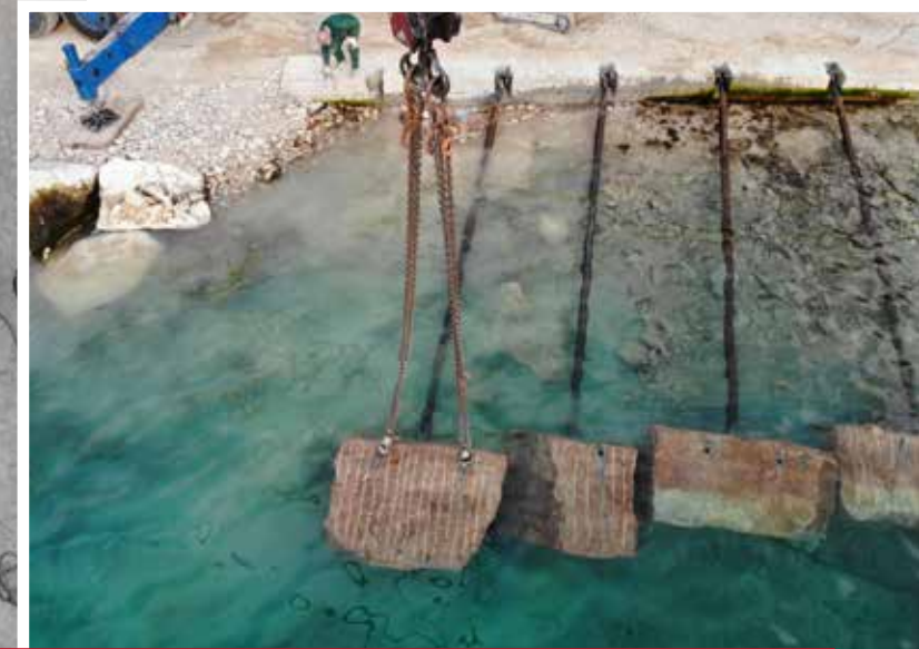
Operazioni di preparazione in terraferma della piastra di contenimento e della barra di prolunga, e successiva posa per sollevamento Onshore preparation operations of the containment plate and the extension bar, and subsequent installation by lifting
