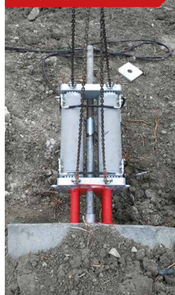
Attivazione piastra flottante su frana Borello a Cesena (FC) Floating plate activation in Borello landslide, Cesena (FC, Italy)
