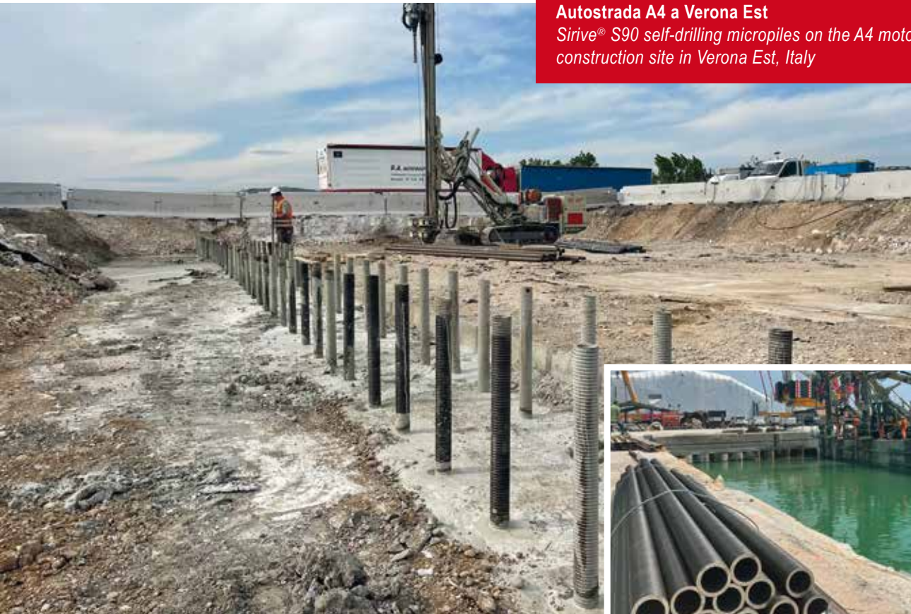
Micropali autopерforanti Sirive® S90 nel porto di Marina di Carrara Sirive® S90 self-drilling micropiles on the port of Marina di Carrara, Italy
