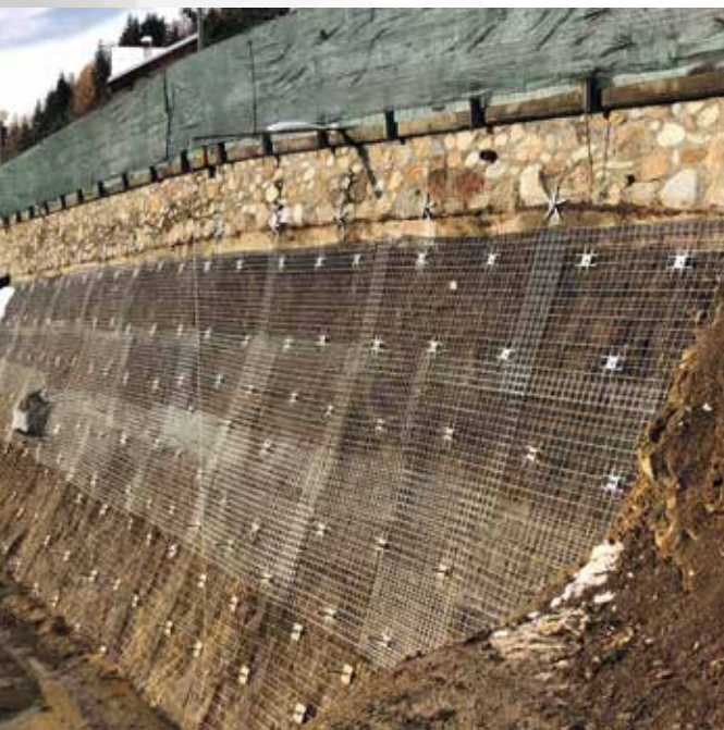
Parete chiodata con rivestimento flessibile secondo EN 14490 e piastre Sirive® Ragno
