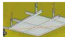
Montaggio di controsoffitti.
