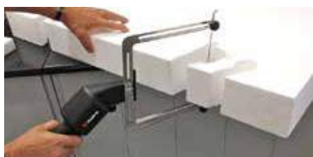
Fig. 7, traforo per tagli verticali
